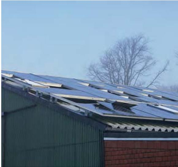
>>1: Reihenweises Versagen der Klebverbindungen nach hoher Windbelastung zwischen Solar-Modulen und Aluminium-Unterkonstruktion infolge gravierender Klebfehler
